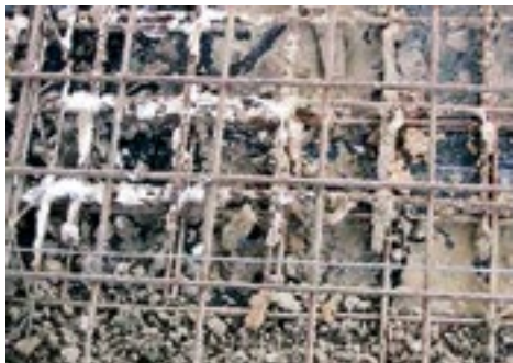
Rys. 6.86. Błędy zabudowy mieszanki betonowej – oblodzone zbrojenie
