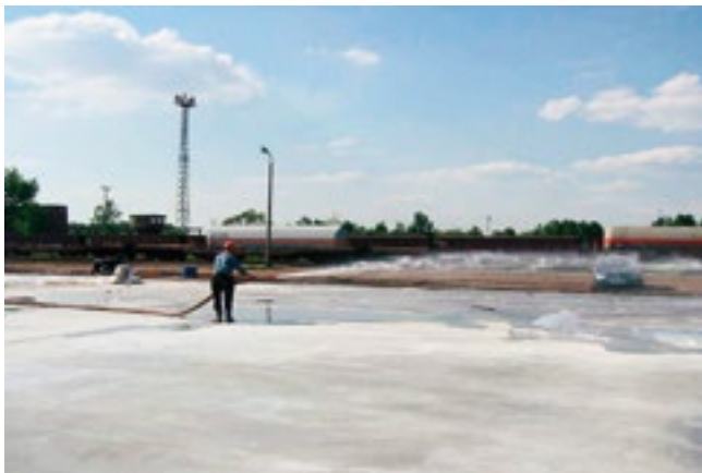
Rys. 6.92. Polewanie powierzchni betonu wodą o odpowiedniej temperaturze
