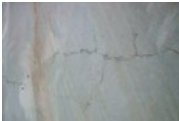
Rys. 6.90. Uszkodzenie powierzchni betonu na skutek „szoku” termicznego
