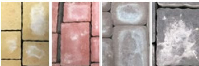
Rys. 6.102. Wykwity węglanowe na powierzchni kostki brukowej
