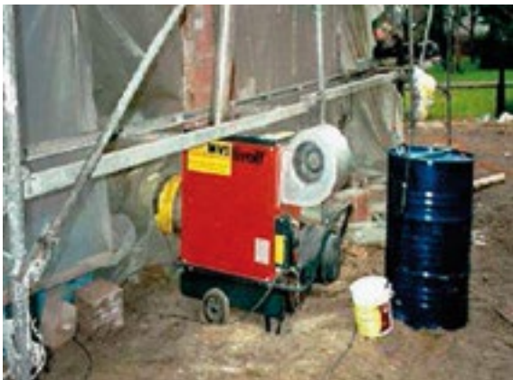
Rys. 6.99. Pielęgnacja betonu za pomocą nadmuchu ciepłego powietrza
