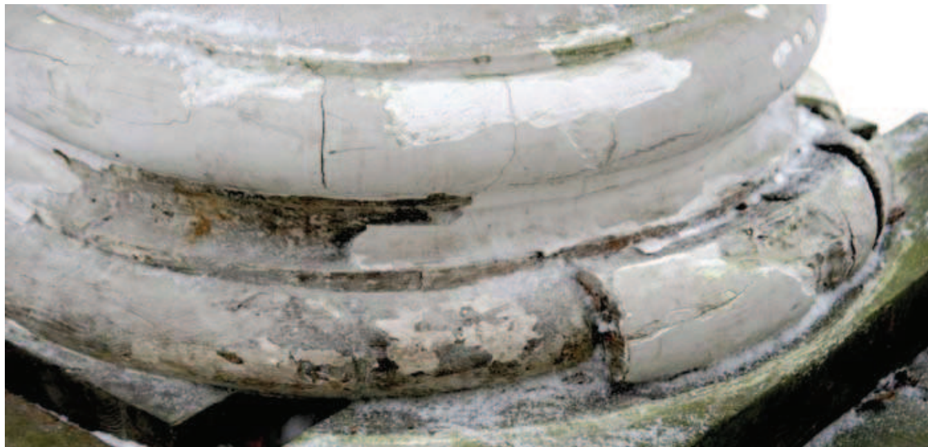
Fot. 56. Detal jednej z baz - ubytki warstw wykończeniowych, spękania drewna.
